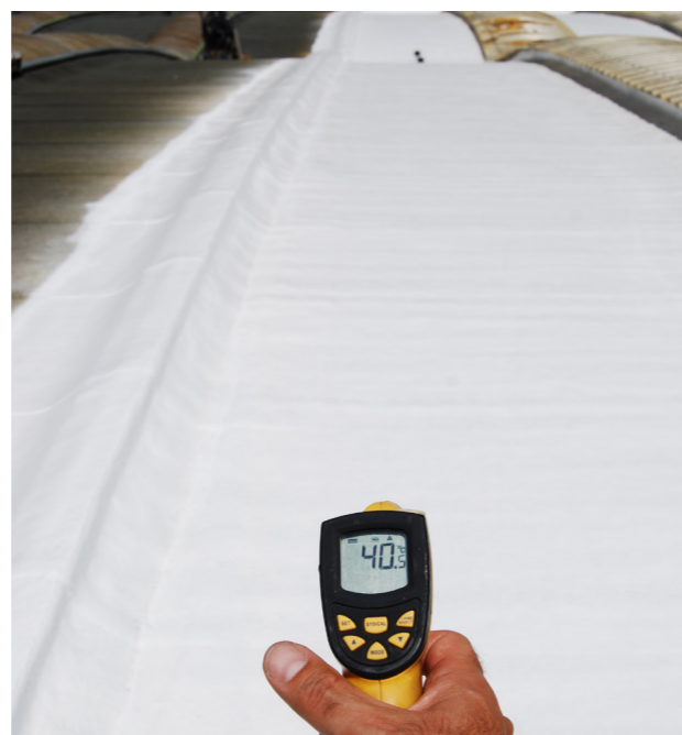
Temperatura e tarracës/ çatisë pas aplikimit të membranës së lëngshme
