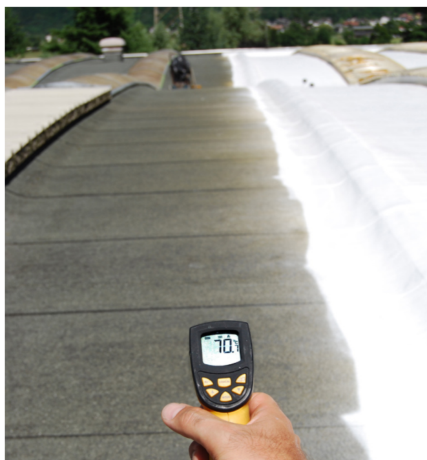
Temperatura e tarracës/ çatisë përpara aplikimit të membranës së lëngshme
