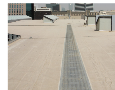
MEMBRANA SINTETIKE
